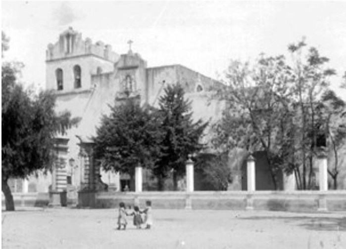
Fachada del templo de San Francisco de Asís en 1910.
